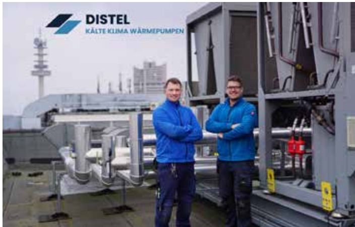
Mitarbeiter der Firma Distel vor einer erfolgreich installierten, leistungsstarken Klimaanlage – Kompetenz und Einsatz für ein optimales Raumklima.
