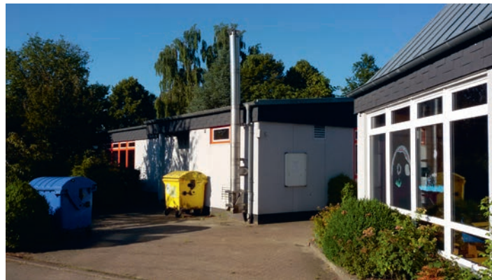
Der Eingang zur alten Kita
