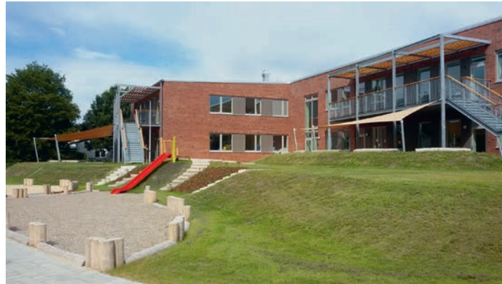
Rückseite mit dem Außengelände
